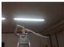
図 3-3 完成した照明 12 台の 取り付けが完了した
