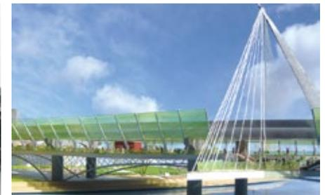
水面に反射するアーチ、空に映るワイヤーの直線。構造の美で阪神高速を美しく表現する。また、大阪はガラス発祥の地。側面を着色されたポリカーボネート板で遮音と修景を考えた。
