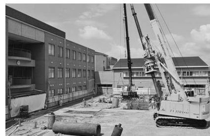
P棟工事現場
