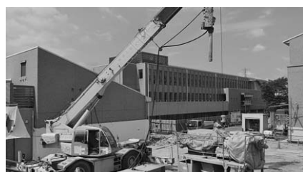
R棟工事現場
